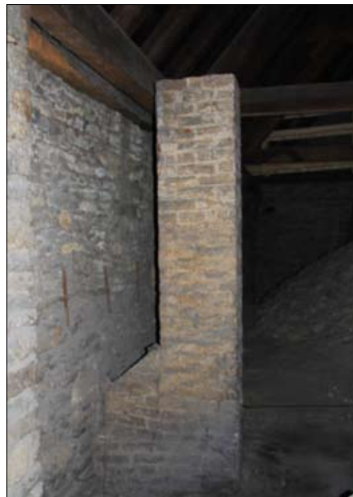
Kamin zur Rauchableitung eines Ofens im Kirchenschiff
