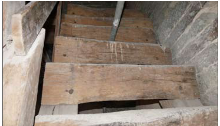
Verbindung zweier Turmgeschosse mittels sog. Blocktreppe aus ca. 1380
